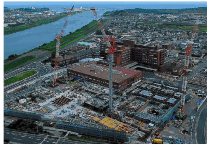
現場状況（敷地中央部及び外来棟東側で鉄骨工事が進んでいます。7/29撮影）
